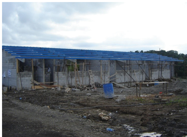
Escuela: Vista de la escuela en construcción, que sería utilizada por los niños y las niñas de la comunidad Tierra y Libertad 31 de Marzo.
